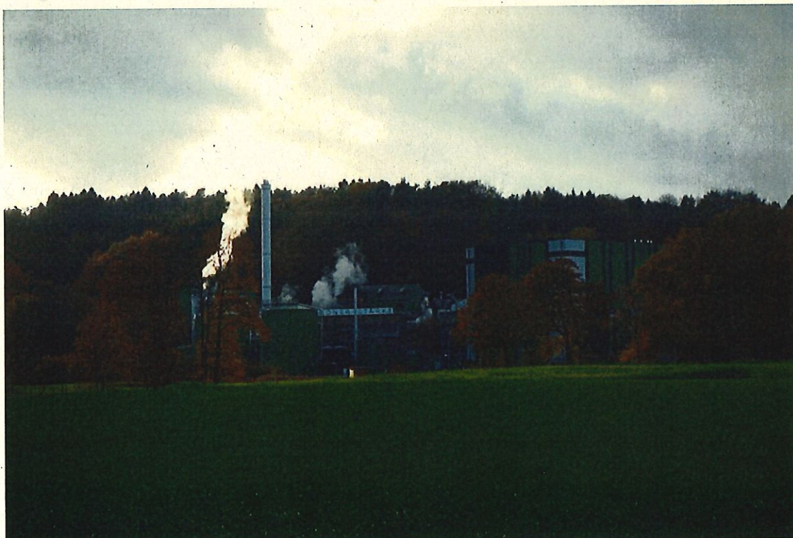
Ansicht aus Nordosten
