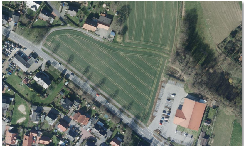
Luftbild vom Standort der zukünftige Seniorenwohnanlage
